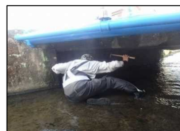
石橋の点検状況
