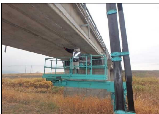
橋梁点検車による定期点検
