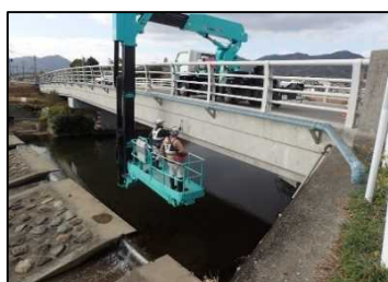
橋梁点検車による点検状況
