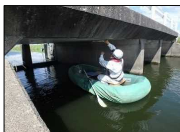
ボートによる点検状況
