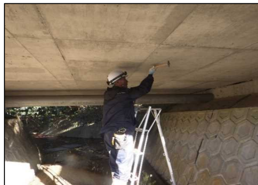
定期点検(打音検査)状況
