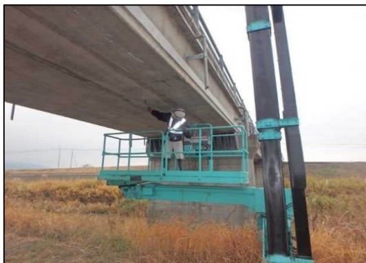
橋梁点検車による定期点検
