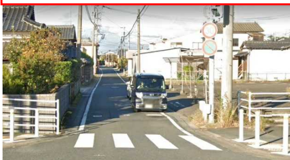
三③田手南交差点(施工後)
