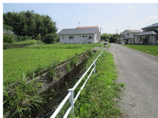
東①町道 川原・横田線(施工前)
