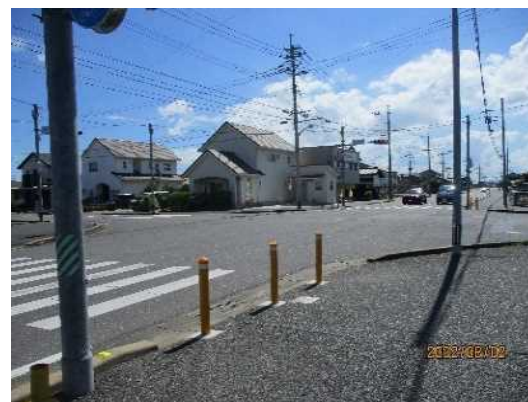
三①三田川小学校南交差点(施工後)
