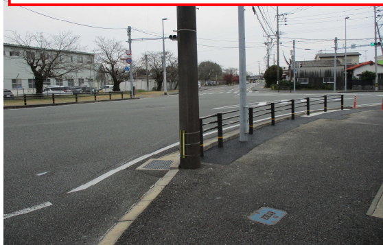
三②国道34号交差点(駅南)(施工後)
