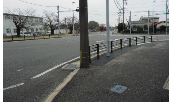
三 R34 交差点(荅野)(施工後)
