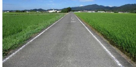
東 学校橋東町道(施工前)
