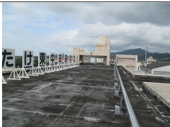
屋上防水：校舎 露出防水層 表面劣化
