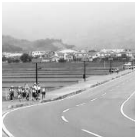
太陽光発電による防犯街路灯
