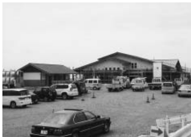
建設中のさざんか干坊館（仮称ふれあいセンター）
