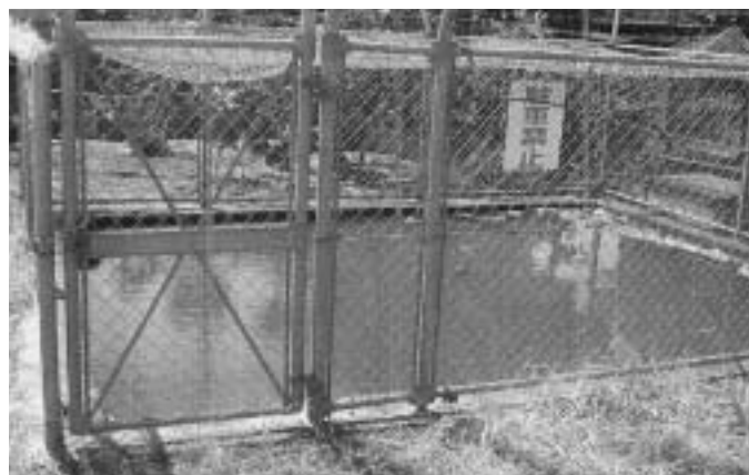
防火用水 (川原団地内)
