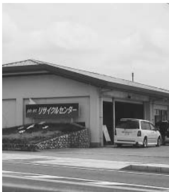
東脊振にあるリサイクルセンター
