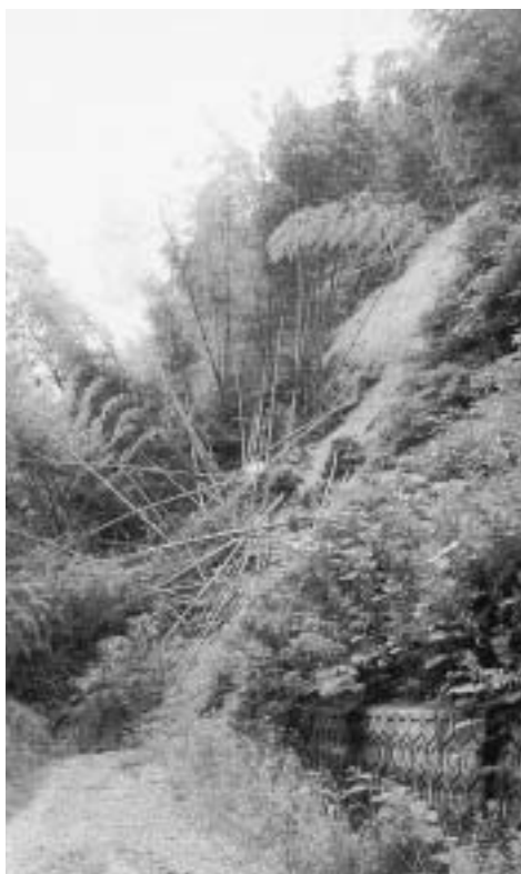
柵の瀬線災害
