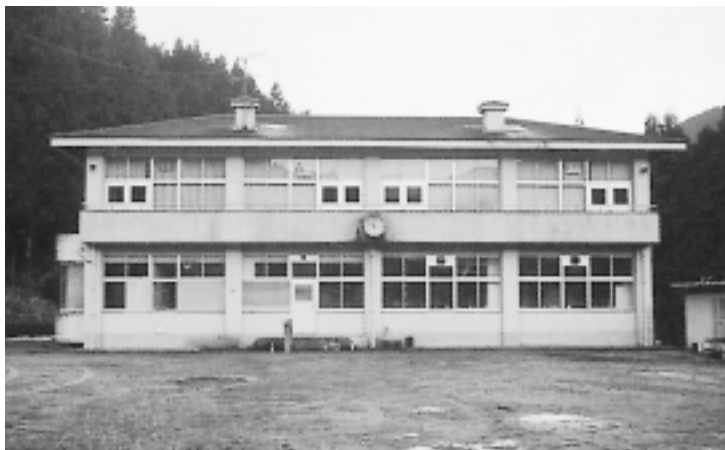
19年度解体予定の小川内小学校
