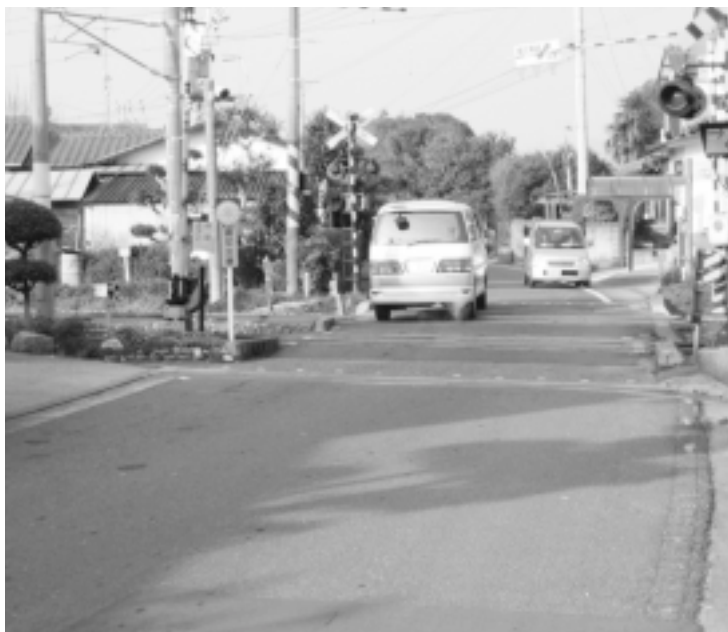
高架を県に要望している、離合の出来ない新町踏切
