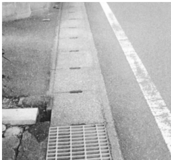
都市下水路との接続箇所（目達原）
