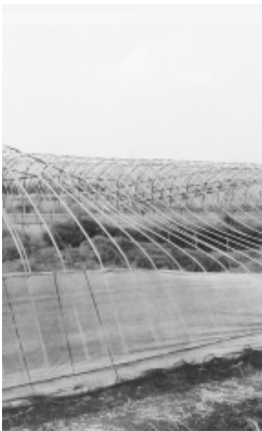
台風13号被害（アスパラハウス）
