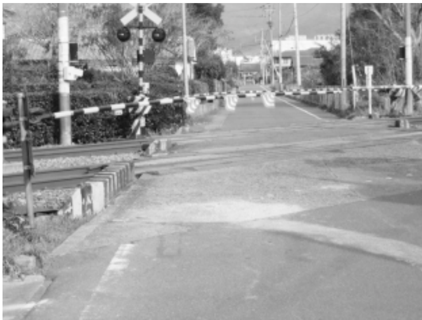
歩道のない踏切（場々踏切）
