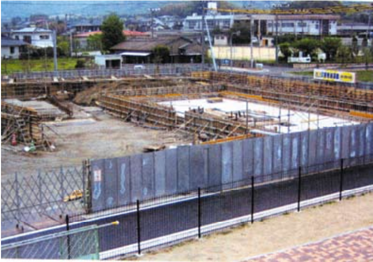
工事がストップした東脊振小学校プール
