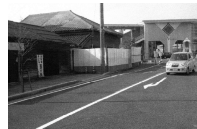
駅南口歩道のバリケード
