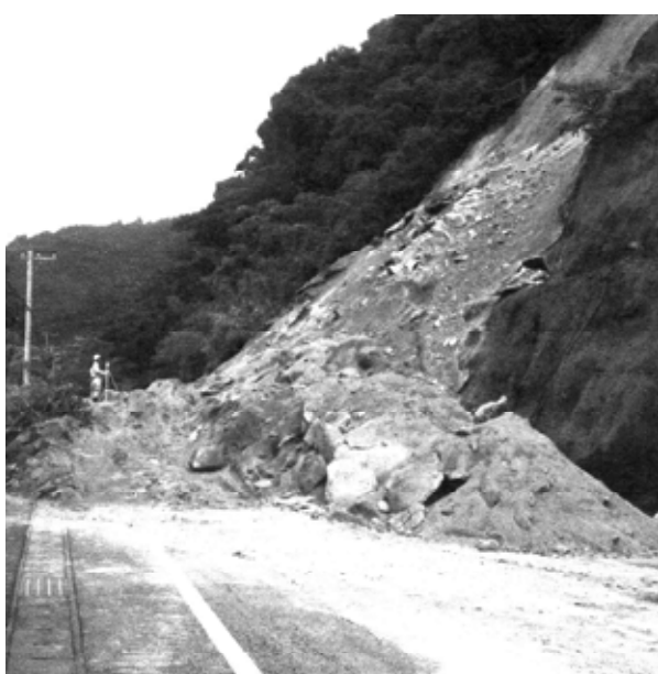
7月4日、集中豪雨で法面が崩壊した国道385号
