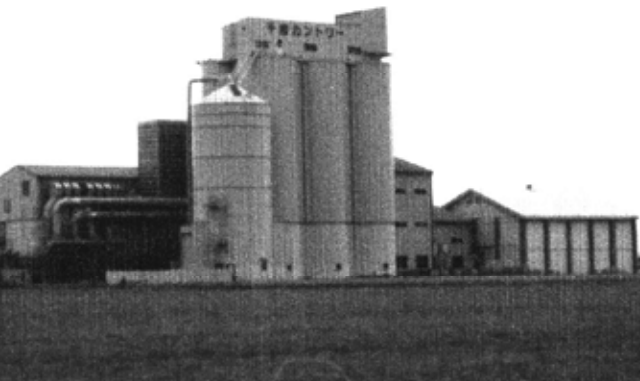
▲平成18年3月竣工 千歳地区カントリーエレベータ
