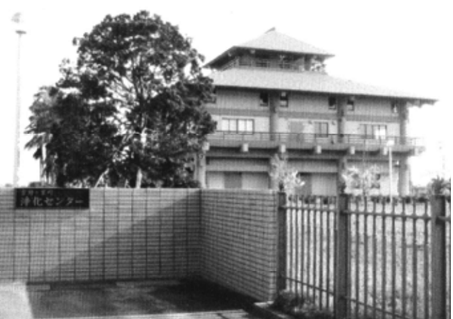
▲吉野ヶ里町浄化センター
