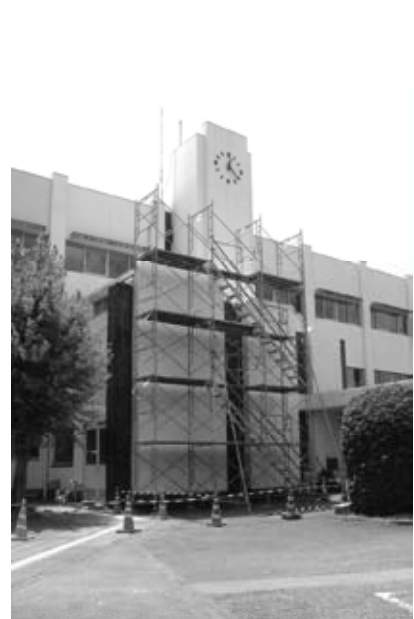
▲耐震工事が始まった三田川中学校
