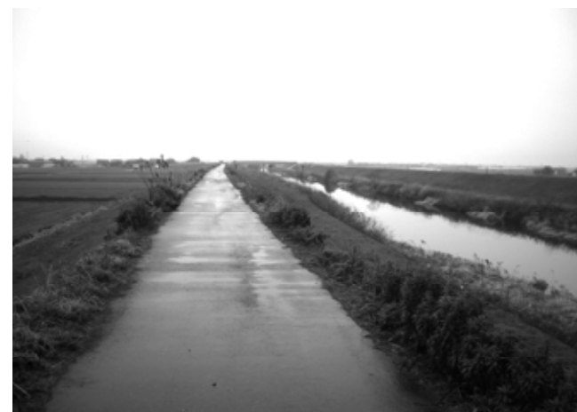
▲町道田手・箱川線(田手川)
