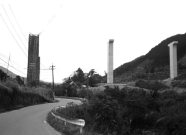
▲着々と進む五ヶ山ダム建設工事
