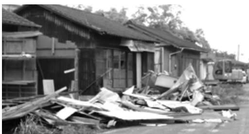
▲解体が進む第8住宅
