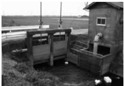
▲改良予定の井堰
