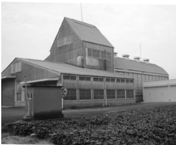
▲昭和50年に建設された中部ライセンサー
