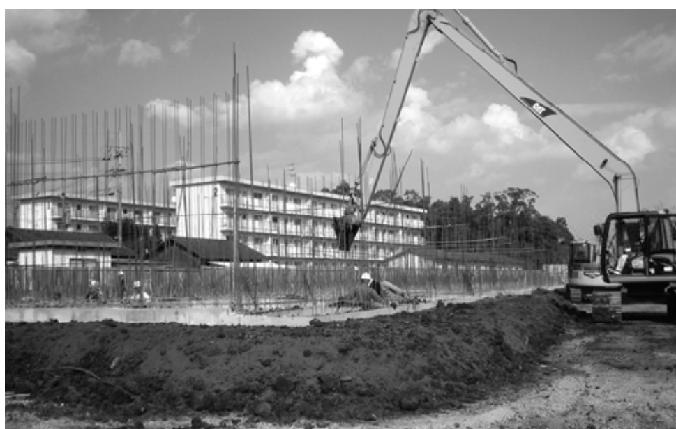
▲「低落札」で建設が進む町営住宅
