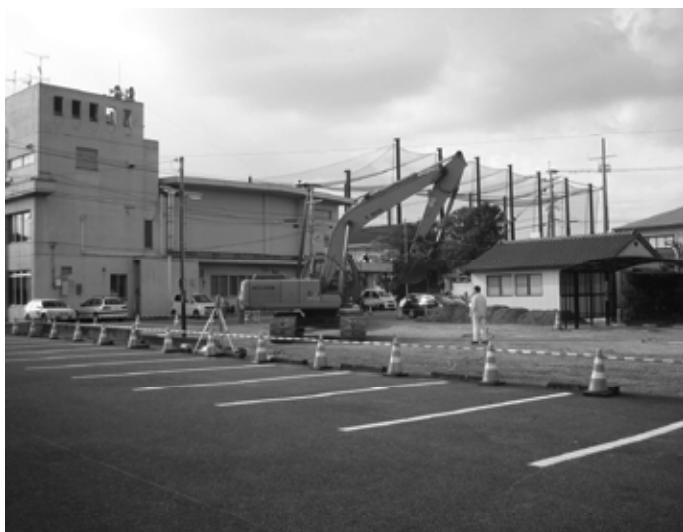
▲カーポート式駐車場工事
