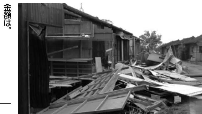
▲解体中の旧第8住宅
