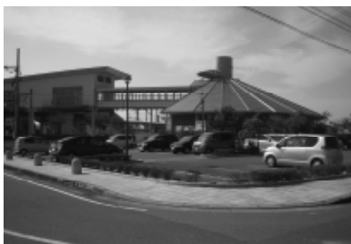
▲駅舎コミュニティホール
