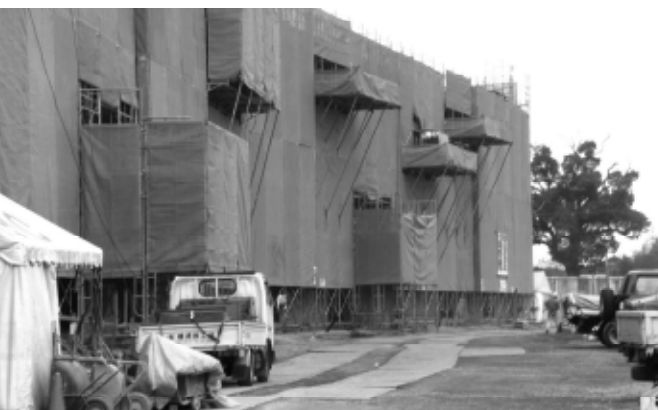
▲建設が進む第8住宅
