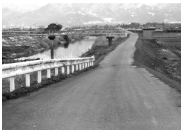
▲田手川堤防(農村地区)
