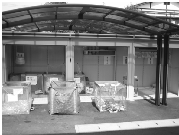
▲三田川庁舎東に新設された資源物回収所
