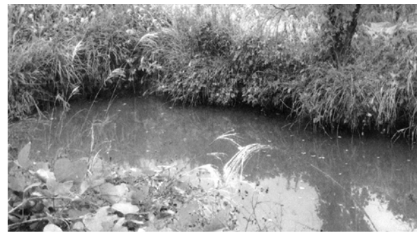
▲素掘りの防火水槽
