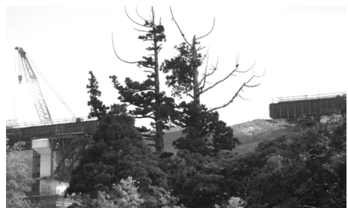
▲ダム湖を跨ぐ佐賀橋の橋梁工事と取り残された小川内の杉
