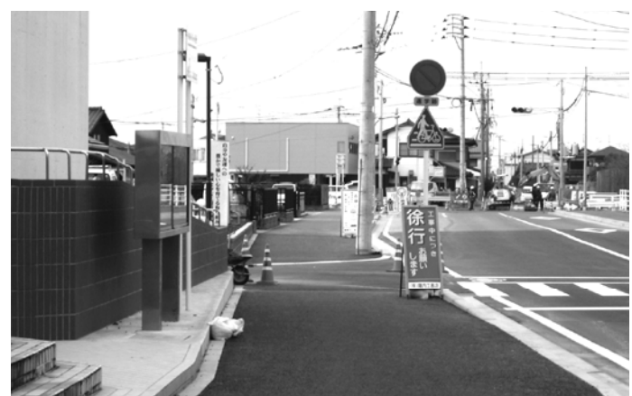
▲再開された町道改良工事（中央公民館北側）
