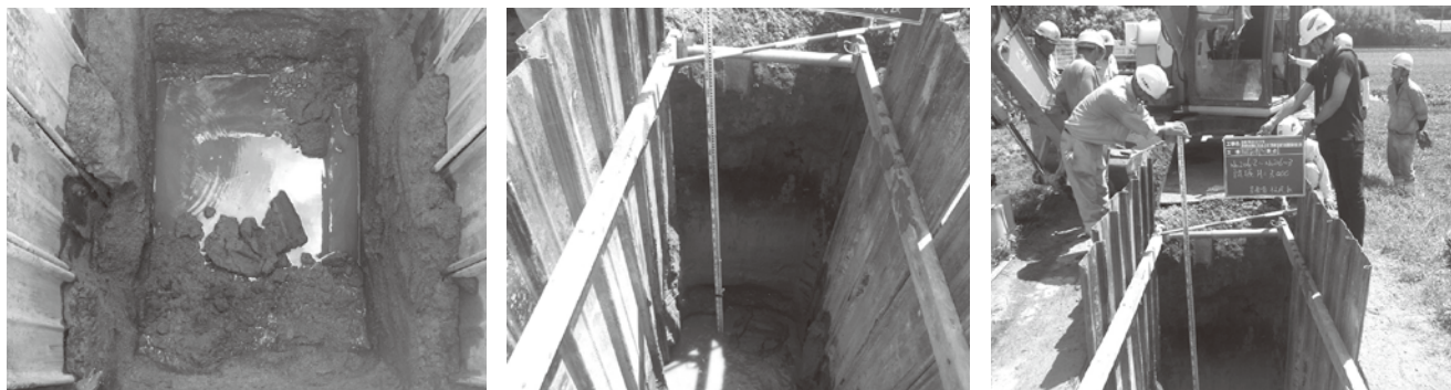
掘削段階で想定以上に、湧水と石が出たため、工事変更が繰り返されている。
