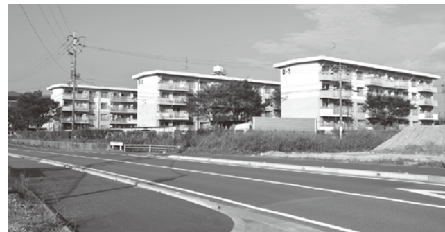
空き室が多い中の原団地 D棟
