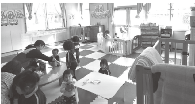
吉野ヶ里保育園雨漏現場（1歳児室）
