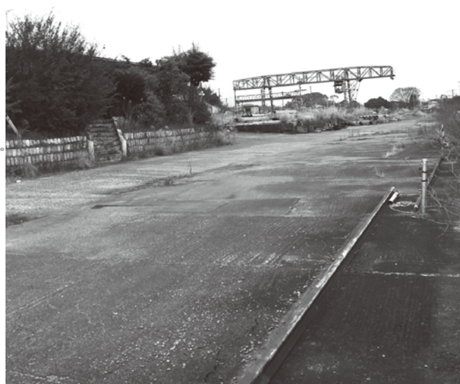
ジャパンパイル工場跡地
