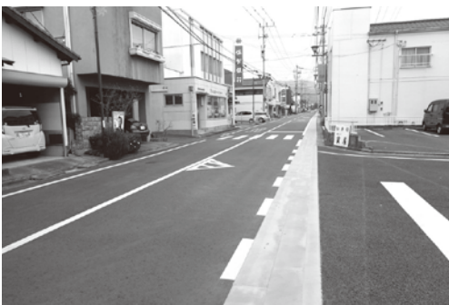
やっとカラー舗装された商店街通り
