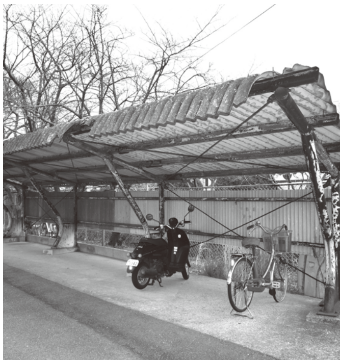
撤去された喫煙所 三田川中学校北入口 東側駐輪場
