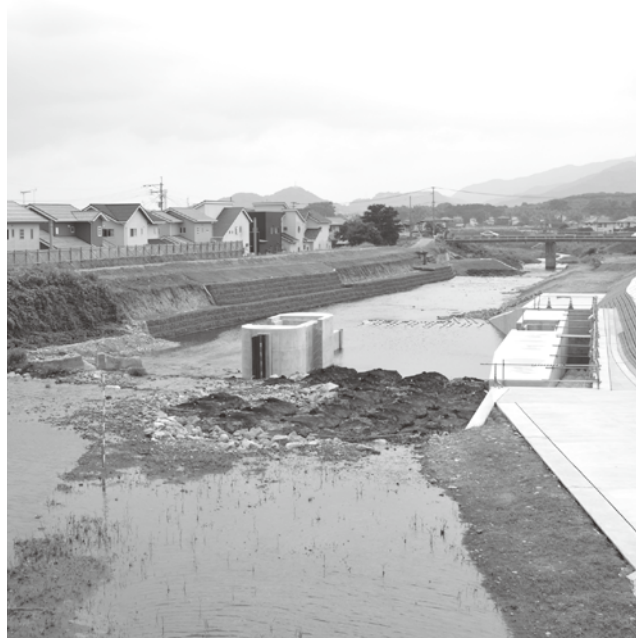
河川改修工事が進む田手川(河原橋)
