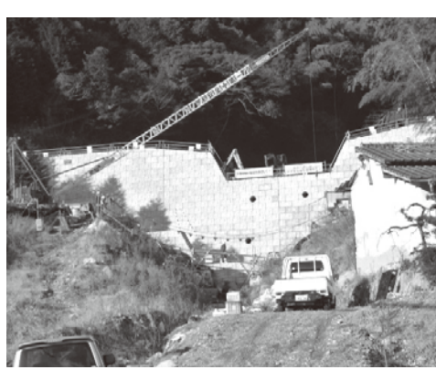
▲土石流災害復旧工事現場
