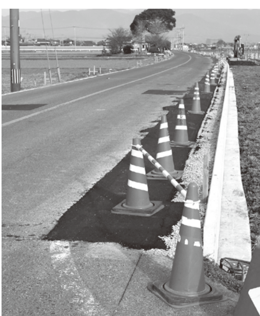
▲箱川地区の道路改修工事
