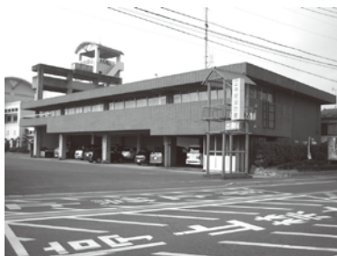
▲解体か 神埼消防本部旧施設
