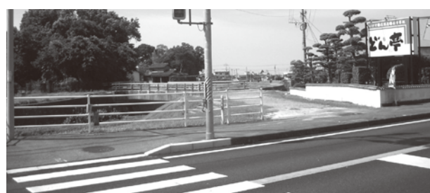
▲国道34号吉田地区井柳川付近
