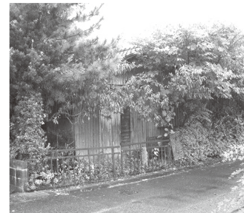
▲管理されていない空き家
