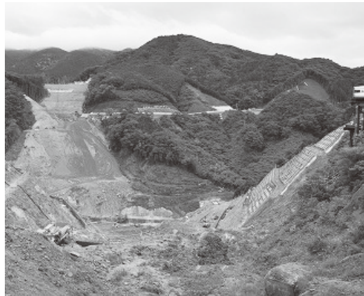
▲着々と進む五ヶ山ダム
