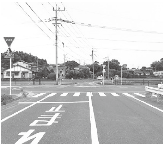
▲途中で途切れている県道吉野ヶ里公園線
