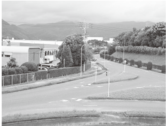
▲公共下水道管渠が布設される町道中核工業団地・目達原
