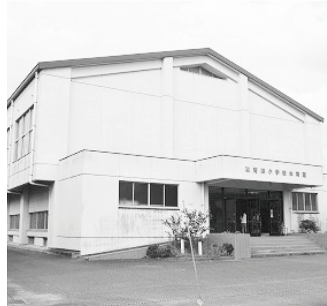
▲早期改修が望まれる東脊振小学校体育館
