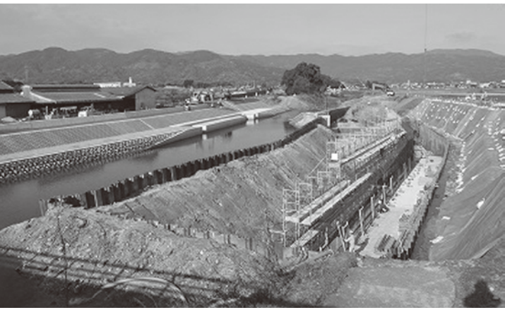
▲河川改修中の田手川
