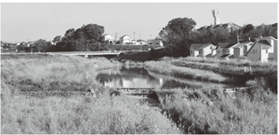
▲改修が待たれる神水川井堰と鴨井手井堰
