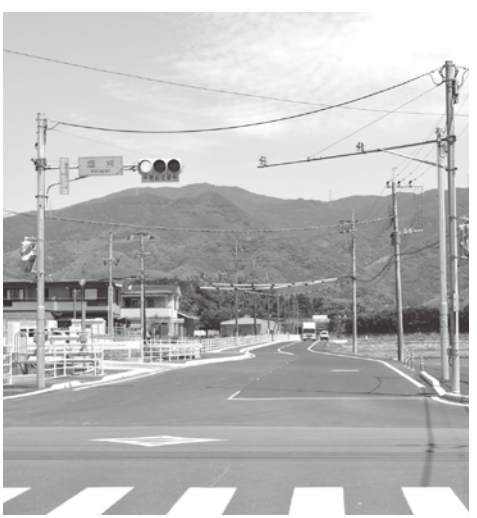
改良された町道大曲・上石動線(畑刈交差点)
