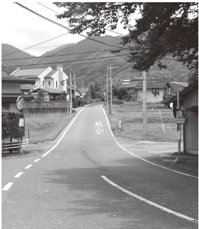
早期改良が待たれる上石動地区県道
