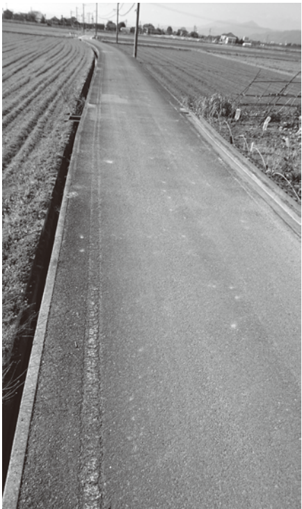
外側線の無い道路
