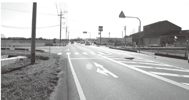
信号機が設置される交差点(東脊振南部ライスセンター前)
