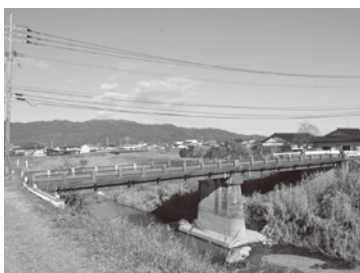
今年度より改修予定の永道橋
