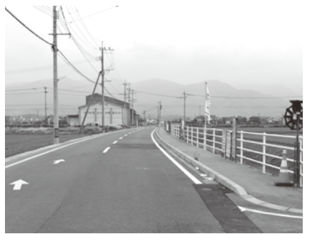
湧き水が発生した道路
