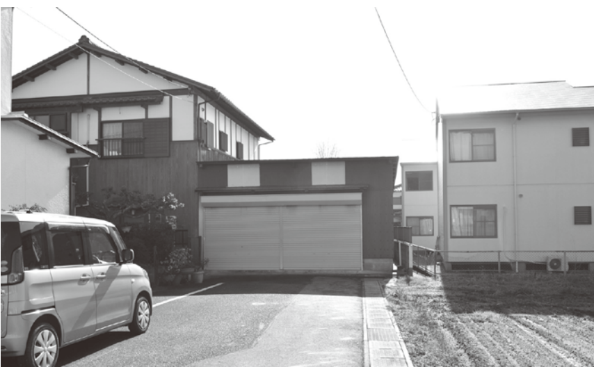
不法建築物と袋小路の全景写真
