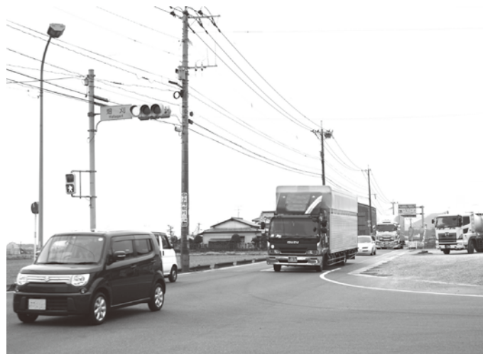
右折レーンがないため 私有地にはみ出し通行している畑刈交差点
