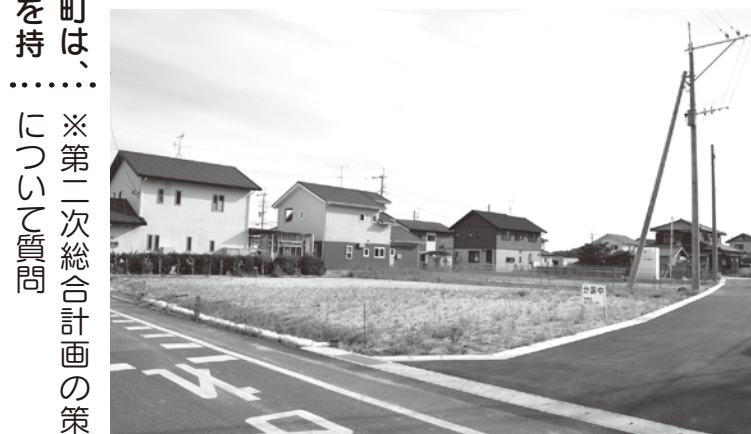
宅地造成中の現場
