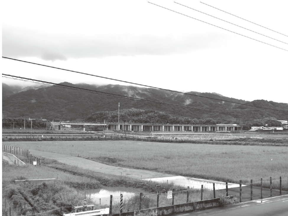
造成工事が完了した文化体育館敷地
