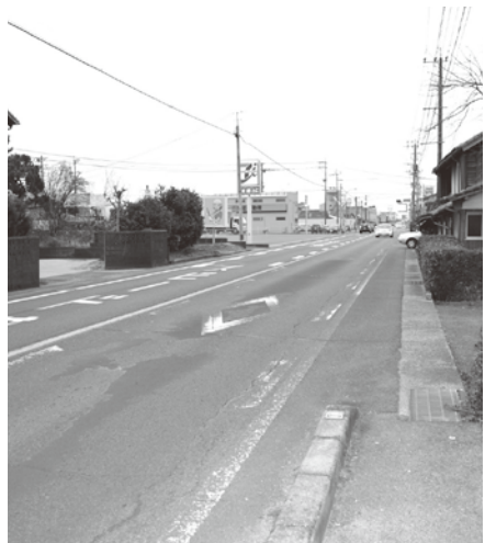
久留米分岐交差点の歩道がない箇所
