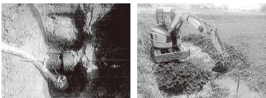
老朽化したヒューム管パイプラインの修理
