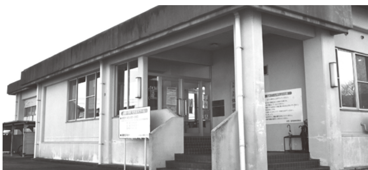
老朽化した温水プール
