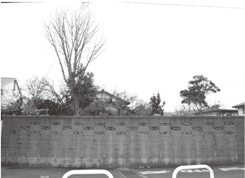
現在の不法建築物(ブロック塀と立木)
