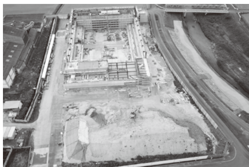
文化体育館建設現場
