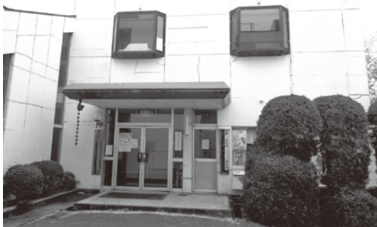
解体となる町民集会所
