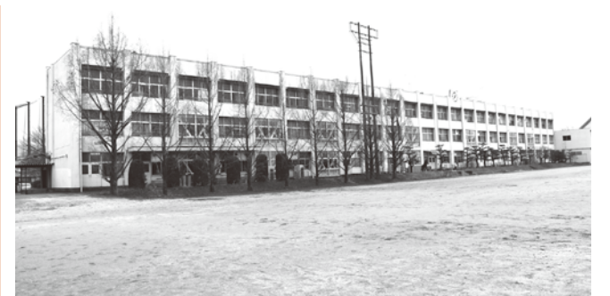
老朽化した昭和48年建設の三田川中学校
