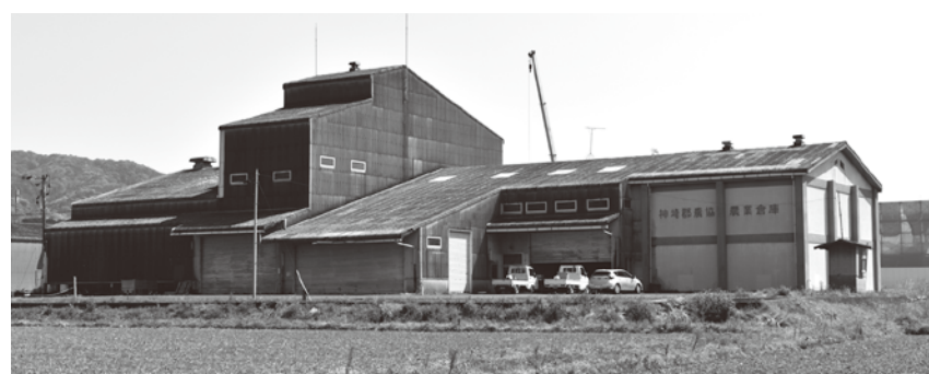
東脊振北部共乾（老朽化によりライスセンター統合化が計画中）
