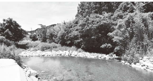
田手川に設置されている干又井堰
