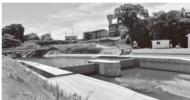
被災後整備された鴨井手堰
