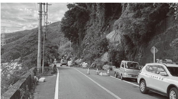
国道385号沿い土砂崩れ状況
