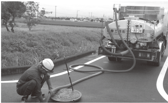
パキュムカーでの処理作業
