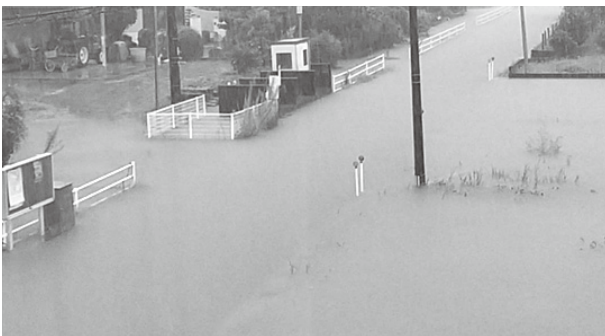
冠水した下藤地区
