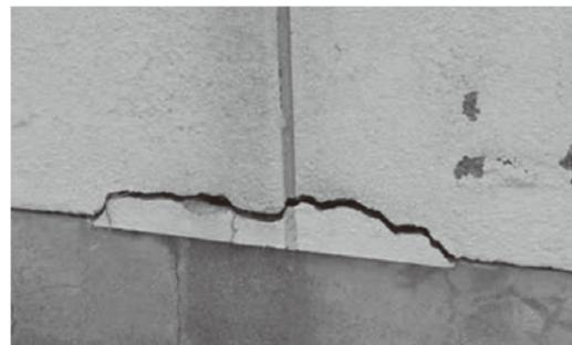
校舎外壁モルタルの亀裂
