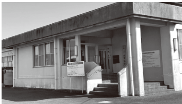
休館中の温水プール
