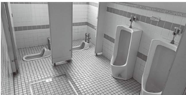
令和5年度に改修が予定されている東脊振中学校のトイレ
