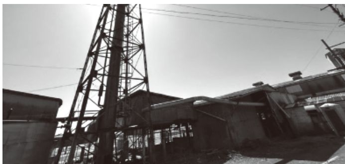
撤去中のジャパンパイル跡地
