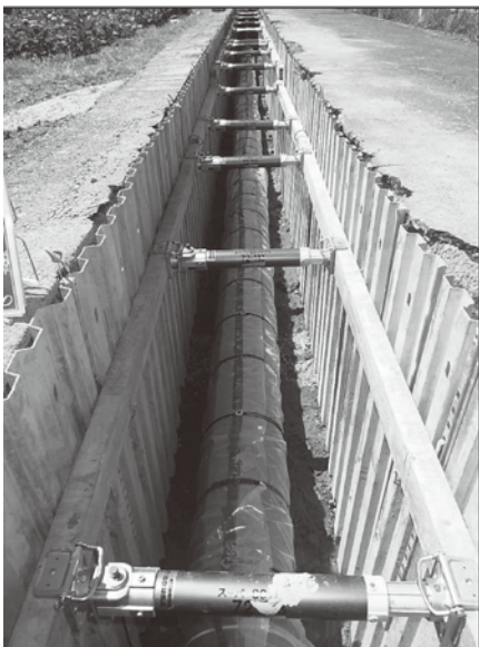
更新工事の様子
