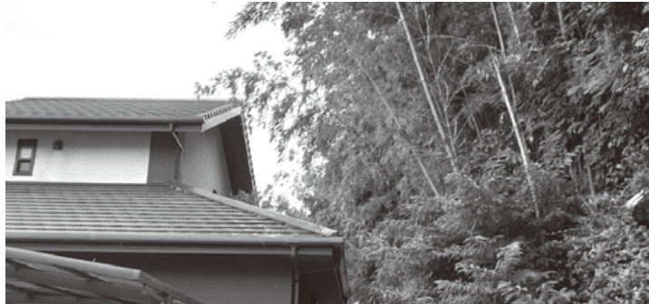
大木の枝が民家に被さっている
