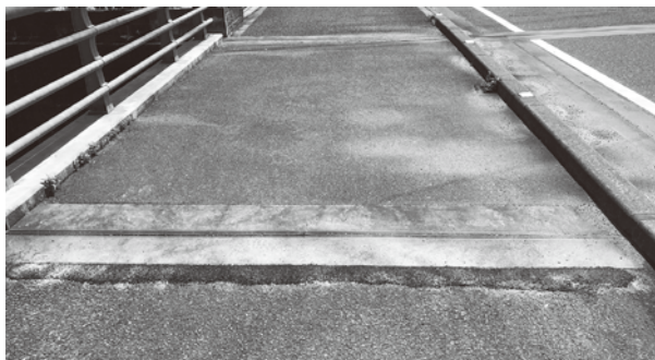
町道苔野・田手村線 補修箇所
