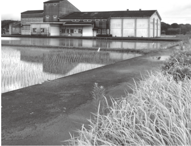
新庁舎が建設される予定地
