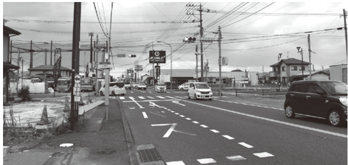
進まない駅前交差点改良工事
