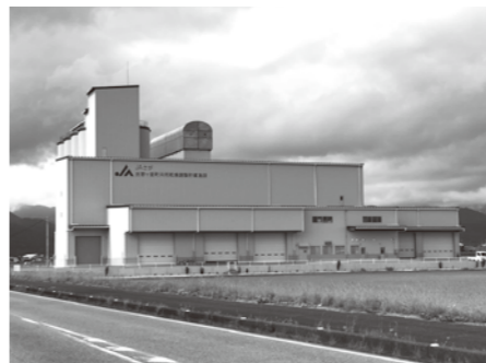
新しく建てられた共同乾燥施設
