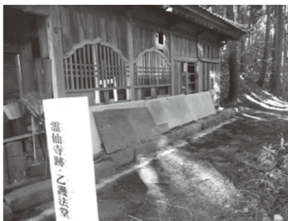
補修予定の乙護法堂
