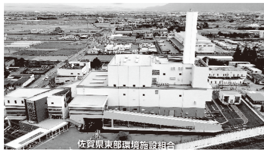
佐賀県東部環境施設組合 佐賀東部クリーンエコランド／外観(カタログより)
