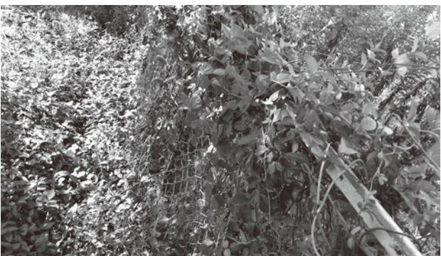
フェンス損傷状況
