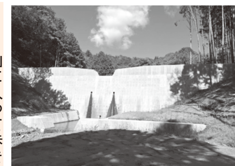
三津の治山ダム
