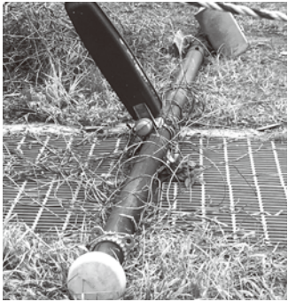
根元から折れた街路灯
