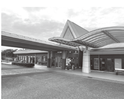
空調工事をするきらら館
