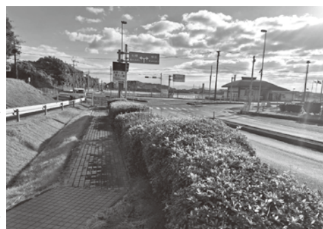
インターから東への道路整備
