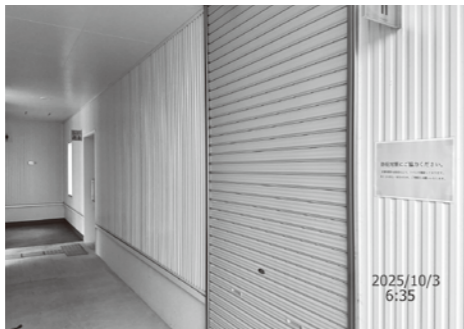
よりみち広場のトイレ
