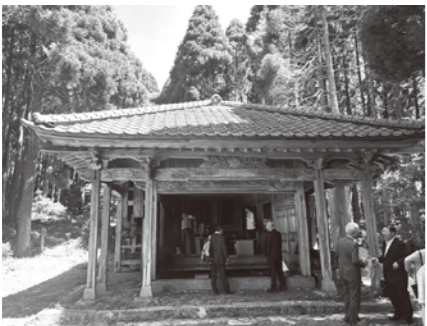
改修が始まる霊仙寺
