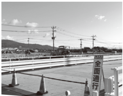
県道神埼北茂安線道路改良工事
