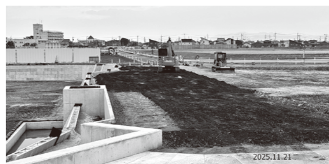
造成中の中央東西道路付近
