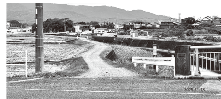
危険な井柳川河川管理道路
