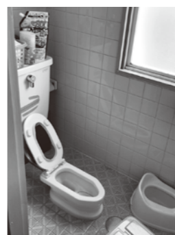
改修する便器
