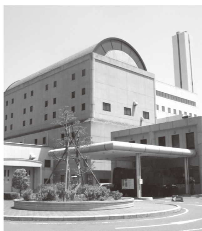
解体される脊振広域クリーンセンター
