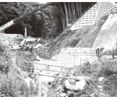
▲工事が進む永山地区
